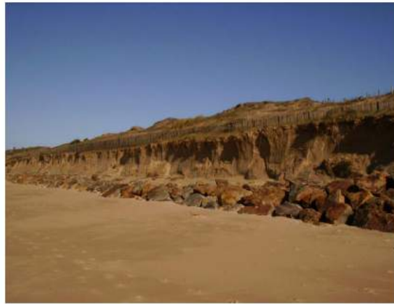
Les dunes ont reculé de plusieurs mètres en arrière des enrochements censés les consolider.
